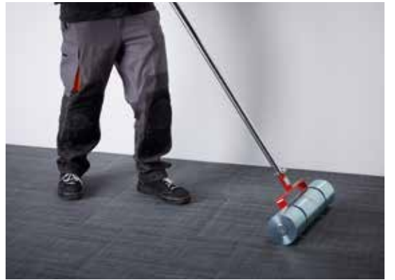
Döşeme alanının tamamını büyük, ağır silindiri kullanarak düzeltin.
