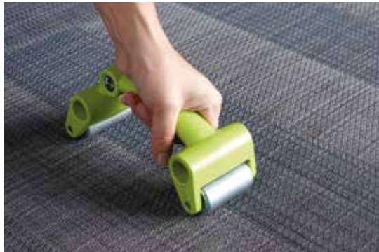
Birleşme yerlerini küçük ek yeri silindiri kullanarak düzeltin.
