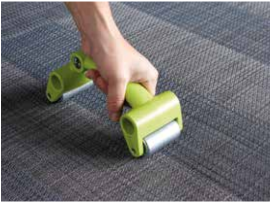
Birleşme yerlerini küçük ek yeri silindiri kullanarak düzeltin.
