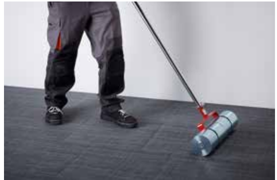
Döşeme alanının tamamını büyük, ağır silindiri kullanarak düzeltin.
