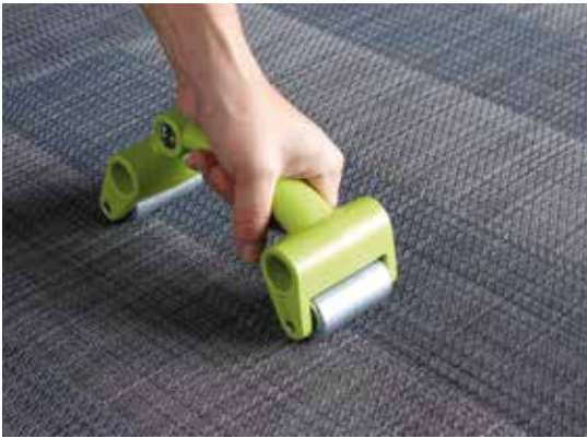
Birleşme yerlerini küçük ek yeri silindirini kullanarak düzeltin.
