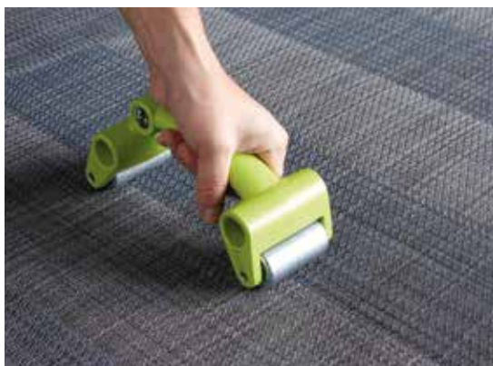
Asentar las juntas con un rodillo prensor pequeño.
