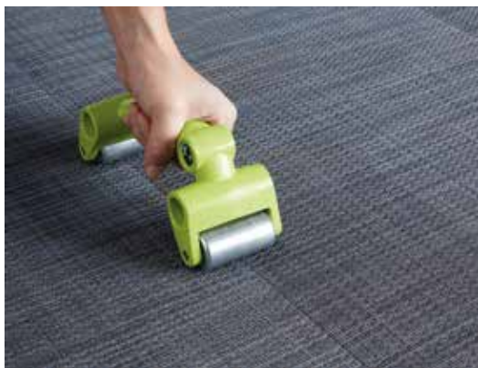
Asentar las juntas con un rodillo prensor pequeño.
