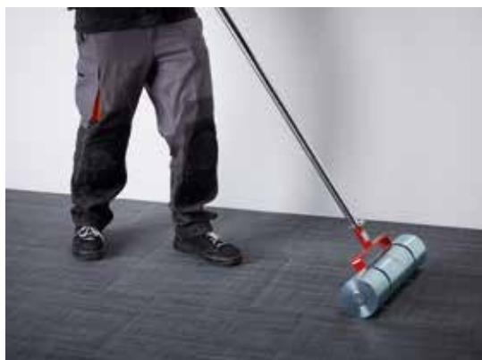
Asentar los hexágonos en toda la superficie recubierta con un rodillo prensor grande.
