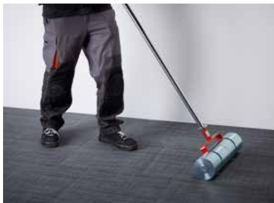
Asentar los Gammas en toda la superficie recubierta con un rodillo prensor grande.
