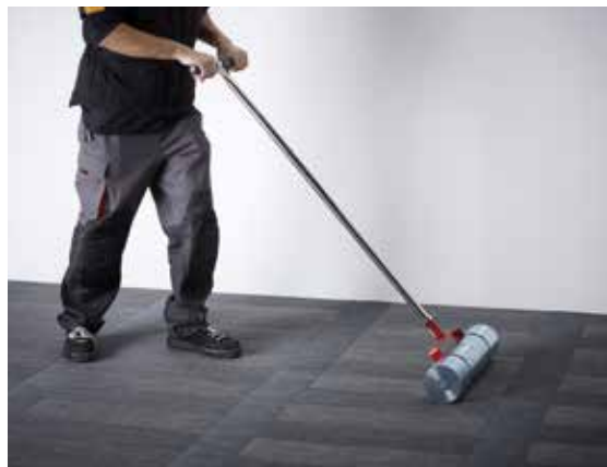
Asentar las lamas en toda la superficie recubierta con un rodillo prensor grande.
