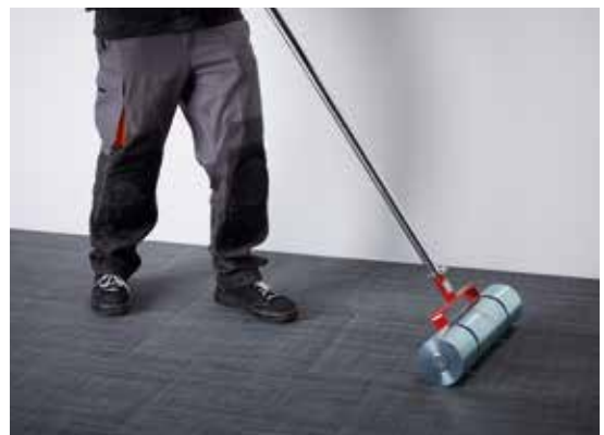
Asentar los hexágonos en toda la superficie recubierta con un rodillo prensor grande.
