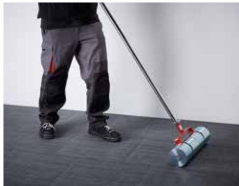
Asentar las losetas en toda la superficie recubierta con un rodillo prensor grande.
