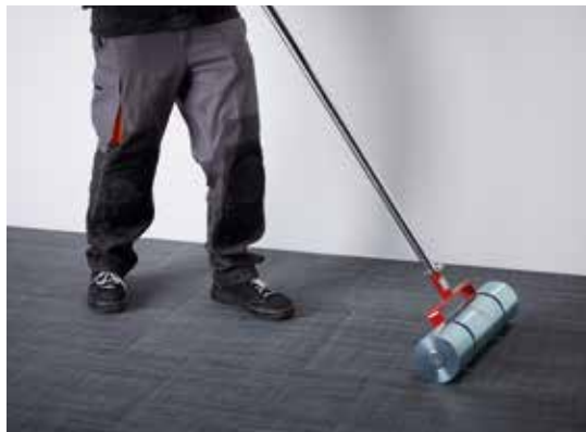
Spianate gli esagoni su tutta la superficie con il rullo da 50 kg.
