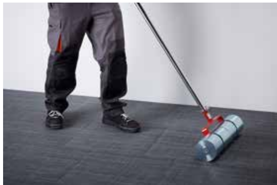
Spianate le strisce su tutta la superficie con il rullo da 50 kg.
