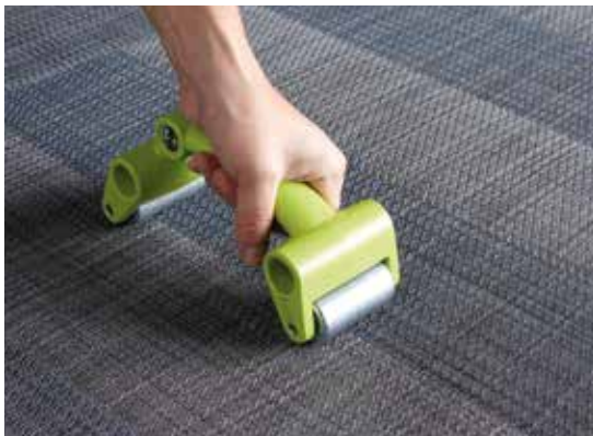
Spianate le giunture, utilizzando il rullo da pressione.
