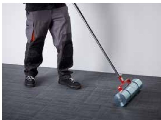
Spianate i pannelli su tutta la superficie con il rullo da 50 kg.
