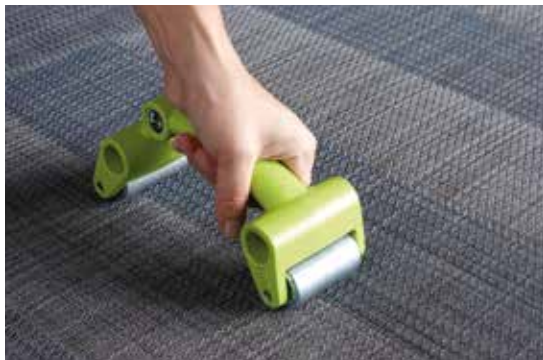
Spianate le giunture, utilizzando il rullo da pressione.
