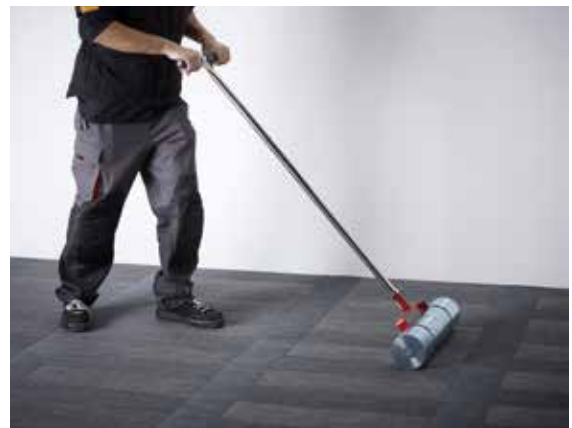
Druk het hele oppervlak aan met de zwaardere aandrukrol.
