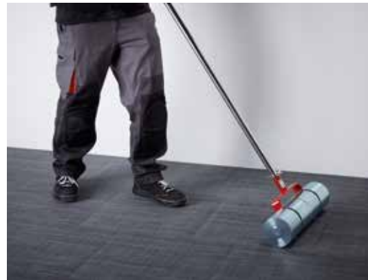
Druk het hele tegeloppervlak aan met de zwaardere aandrukrol.
