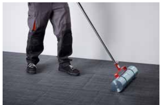
Druk het hele oppervlak aan met de zwaardere aandrukrol.
