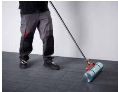
Druk het hele oppervlak aan met de zwaardere aandrukrol.
