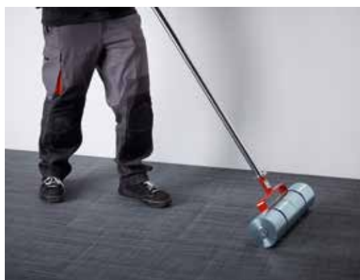
Druk het hele tegeloppervlak aan met de zwaardere aandrukrol
